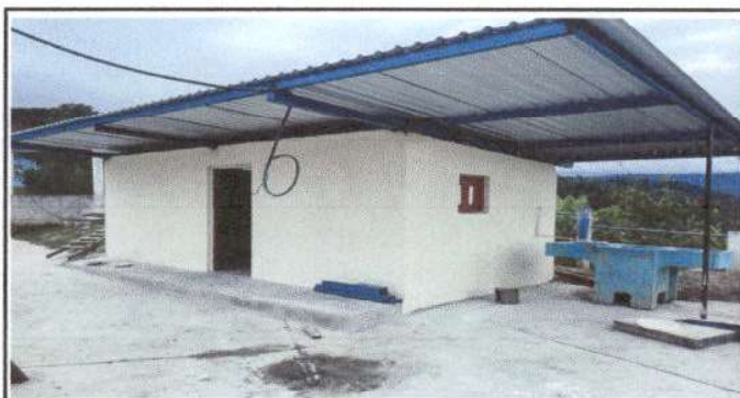
Foto 4: Terminación de cambio de madera por metal módulo de cocina.
