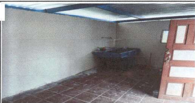
Foto 11: Terminación de aplicación de pintura en muros interiores en módulo de cocina.
