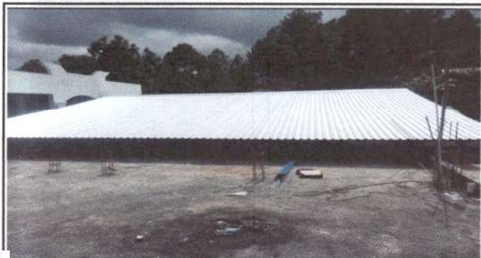
Foto 1: Culminación de sustitución de lámina por lámina troquelada aluzinc calibre 26 área de patio.
