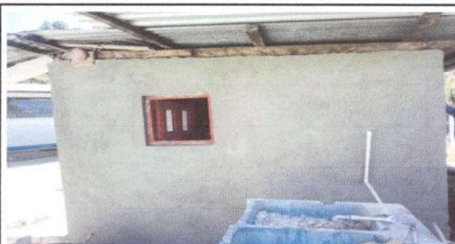
Foto 10: Terminación de repello y cernido de paredes módulo de cocina.
