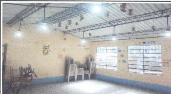
Foto 8: Culminación de cambio de focos ahorradores en módulo de aulas.
