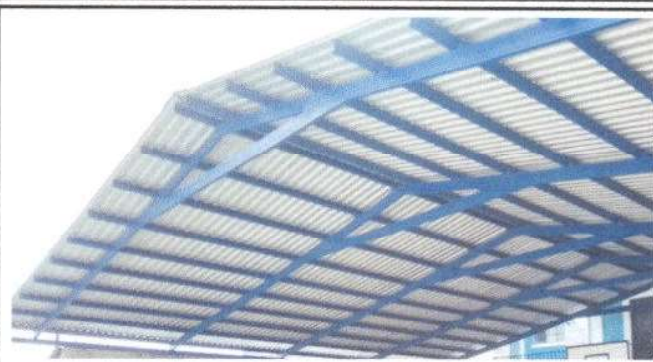
Foto 2: Culminación de cambio de estructura de madera por metal área de patio.
