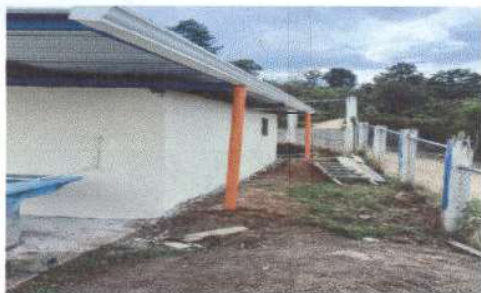
Foto 7: Culminación de sustitución de canal pvc y bajadas de agua pluvial en módulo de cocina.
