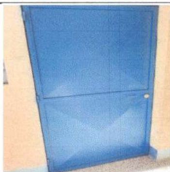
Foto 9: Terminación de sustitución de chapa puerta módulo de aulas.
