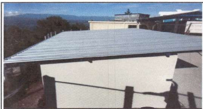
Foto 3: Terminación de sustitución de lámina por lámina troquelada aluzinc calibre 26 módulo de cocina.
